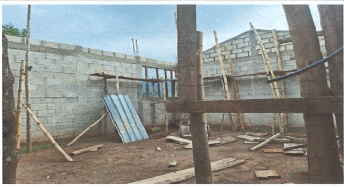
Foto 2: Levantamiento de cablete
