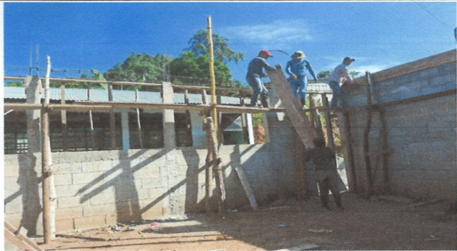
Foto1: Fundición de dintel
