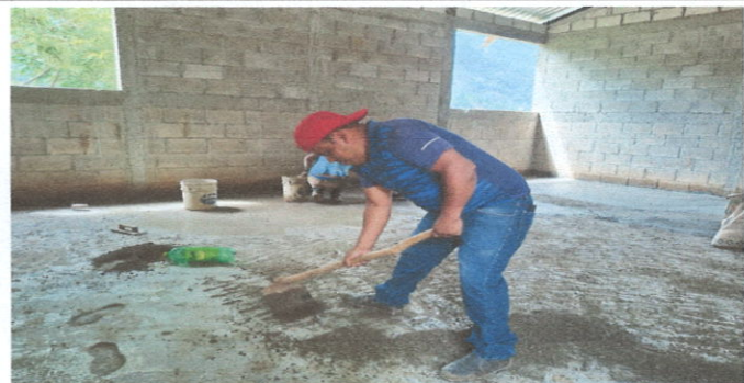
Foto 5: Fundición de piso
