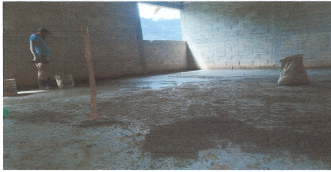
Foto 6: Alisado de piso
